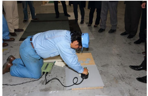
写真 3 塩化ビニルシート防水機械固定工法
