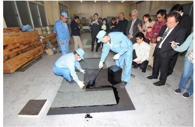
写真 2 アスファルト防水熱工法施工状況
