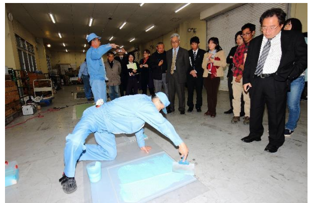
写真 4 ウレタンゴム塗膜防水工法施工状況
